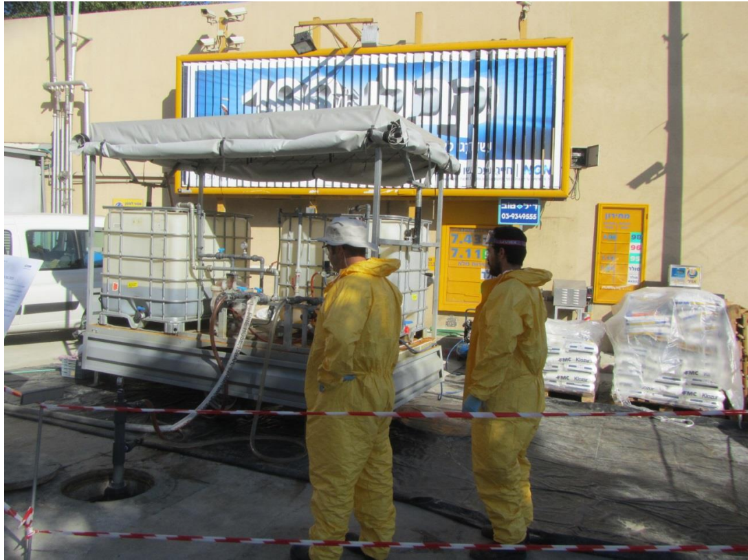
איור 13 : הזרקת מחמצן פרסולפט בתחנת דלק להורדת ריכוז MTBE במי התהום
