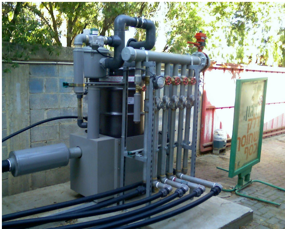
איור 10 : מערכת SVE & AIR SPARGING לטיפול בזיהום דלק במי תהום בתחנת דלק רמת אביב.
